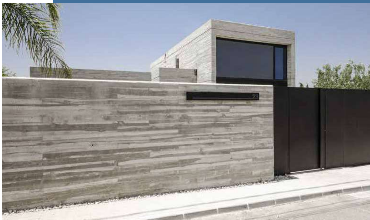
Valla de bloques de muro de hormigón
