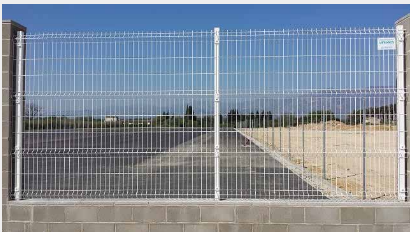
Valla metálica sobre muro de bloque
