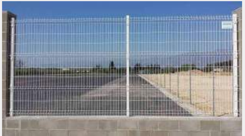
Valla metálica sobre muro de bloque
