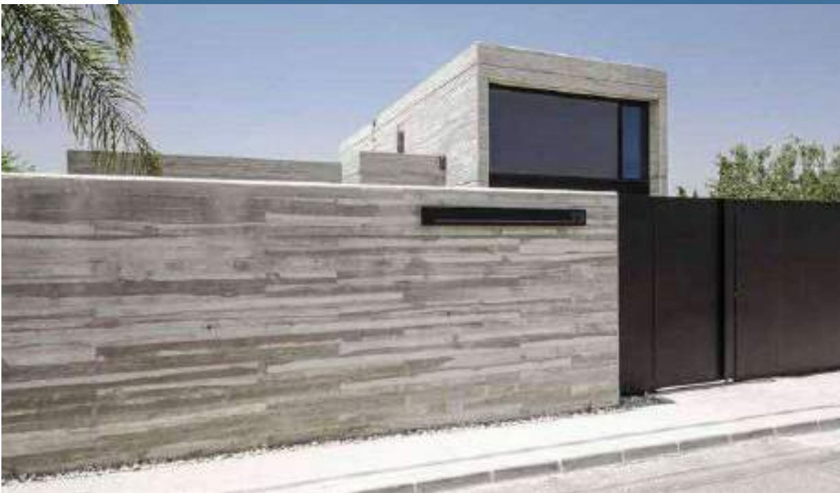
Valla de bloques de muro de hormigón
